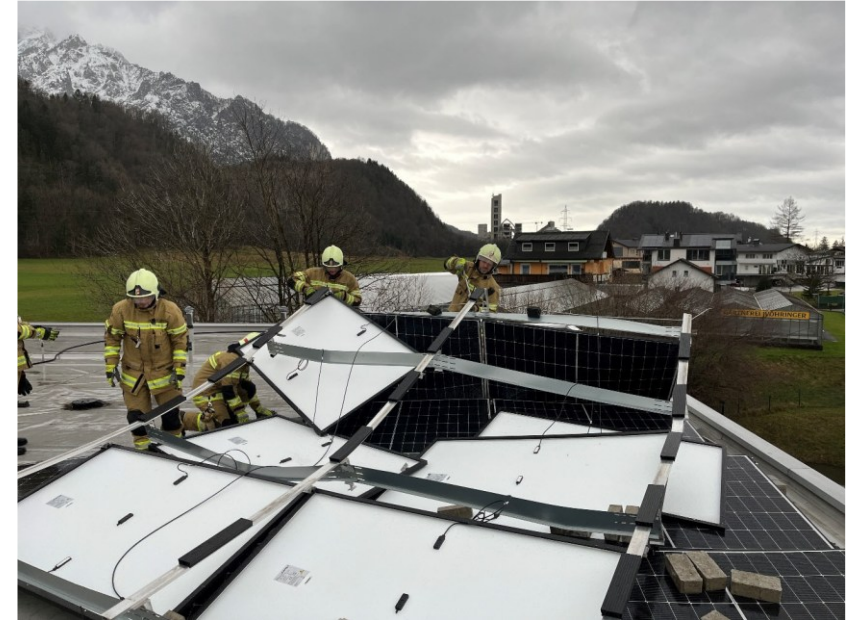
PV-Module nach einem Sturm (Josef Tschematschar - Feuerwehr Hallein)
