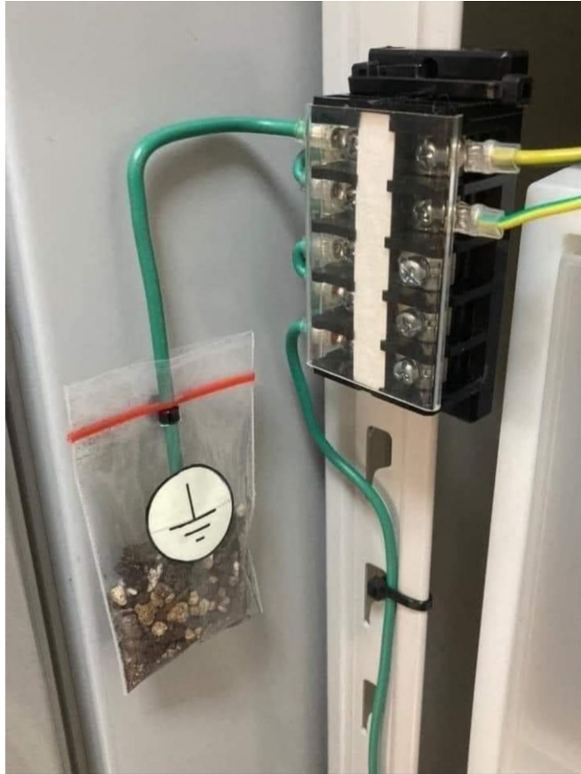
hochwassersichere Erdung
